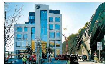
EUREKA: Agderforsknings administrasjonssjef påpeker at oppsigelsen ikke nødvendigvis betyr at de skal flytte fra Eurekabygget.
