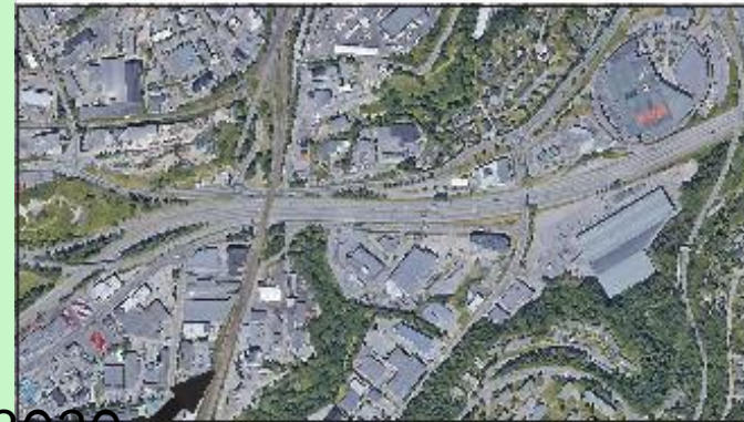
I dette området tenker man at Breivoll stasjon skal ligge.
