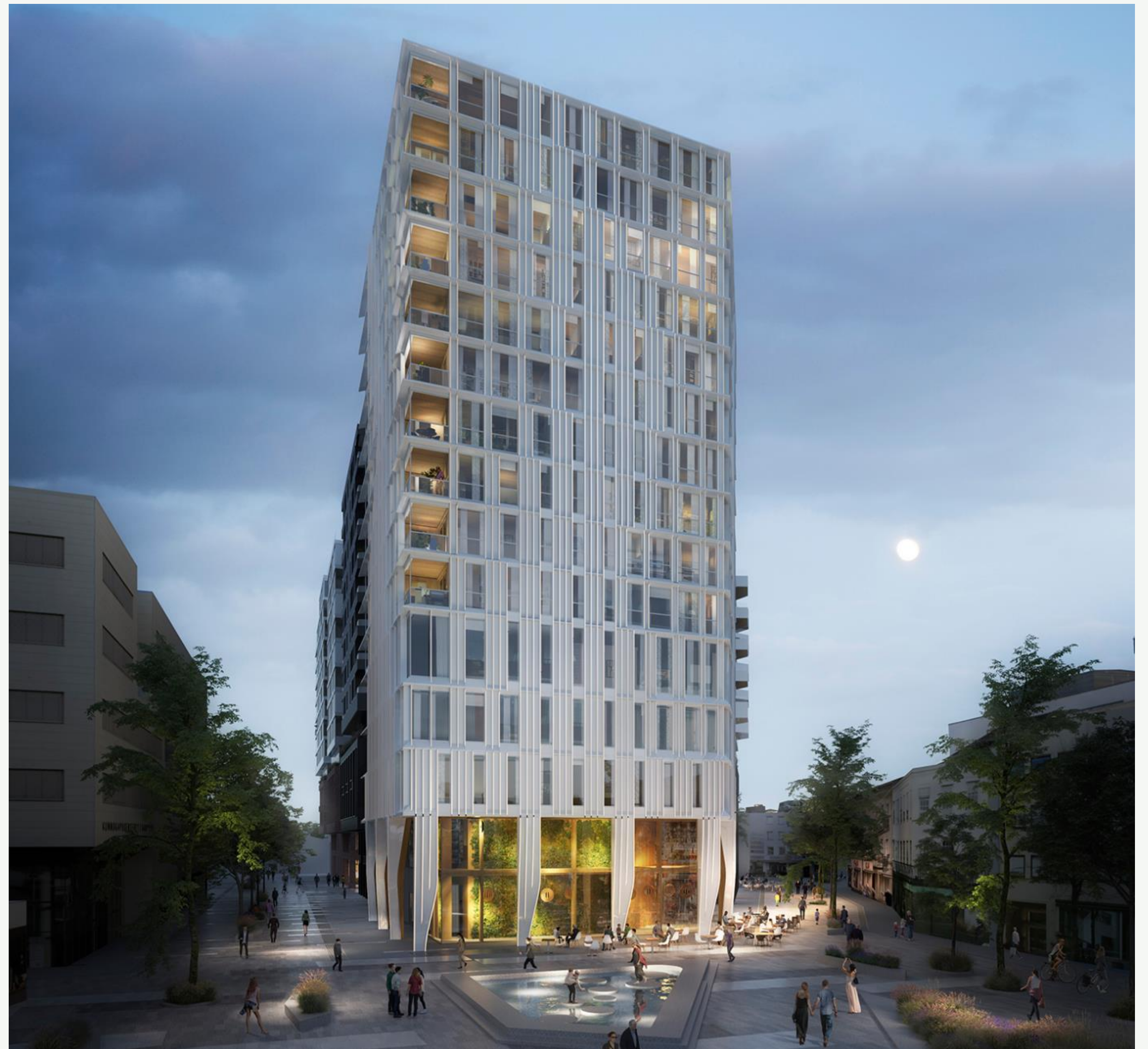
Nye «Helgerudgården» sett fra jernbanestasjonen
