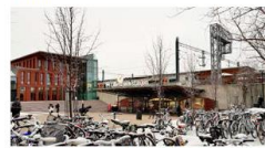
Selve undergangen er ikke spesielt omgitt i reguleringsplanen som gjelder for sporområdene, men bredden er vist i plankart. Den ombygde lokalstallen ses til venstre i bildet.
