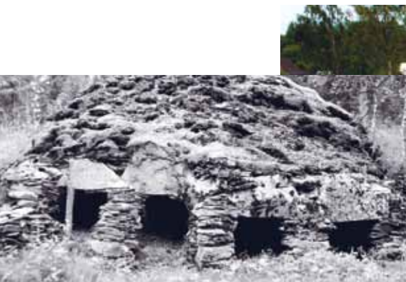
Kalkugn från Åse i Jämtland. Förmodligen har bränningen misslyckats så att kalkstenen blivit kvar. (Foto Jahne Nilsson/Jamtli)
