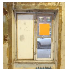
Fönstertyper som ska restaureras
