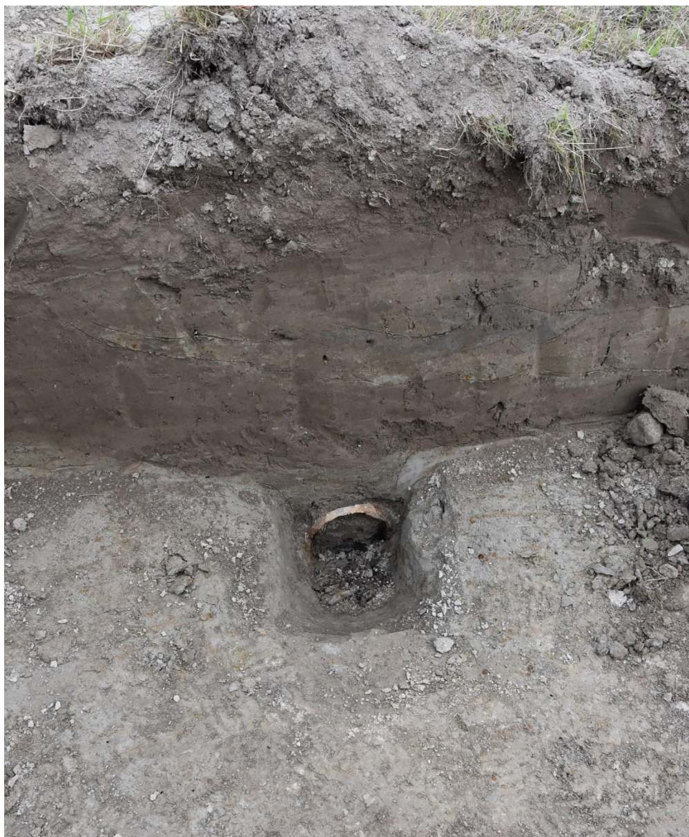
Figur 7. Järnring från den gamla vattenledningen i norra delen av schakt 1. Järnringen hade en ytterdiameter på 223 mm. Foto från väster.
