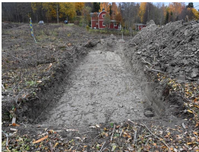
Figur 12. Schakt nedanför Raä 118, från söder.
