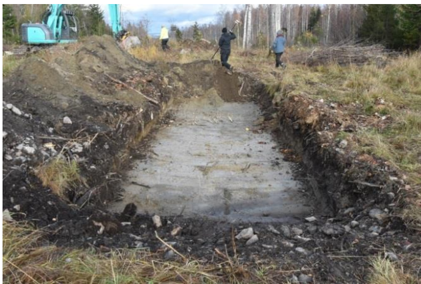
Figur 26. Schakt på område 7 Härsta, från söder.
