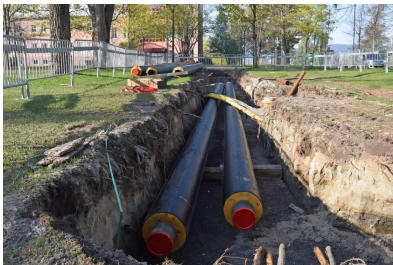
Figur 4. Schakt 3 parallellt med Brunnshusgatan.
