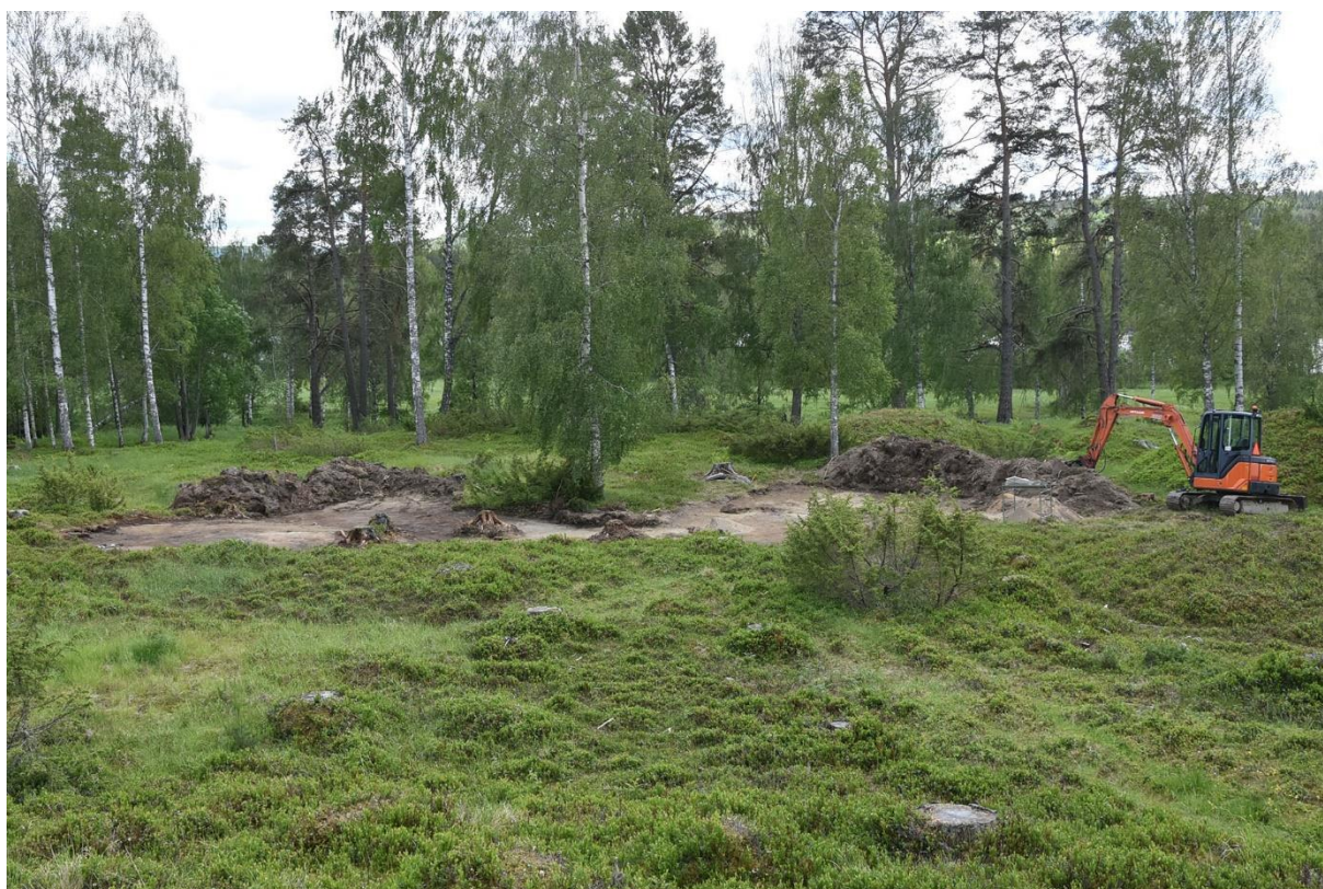
Figur 3. Översikt av schaktet. Foto från norr.
