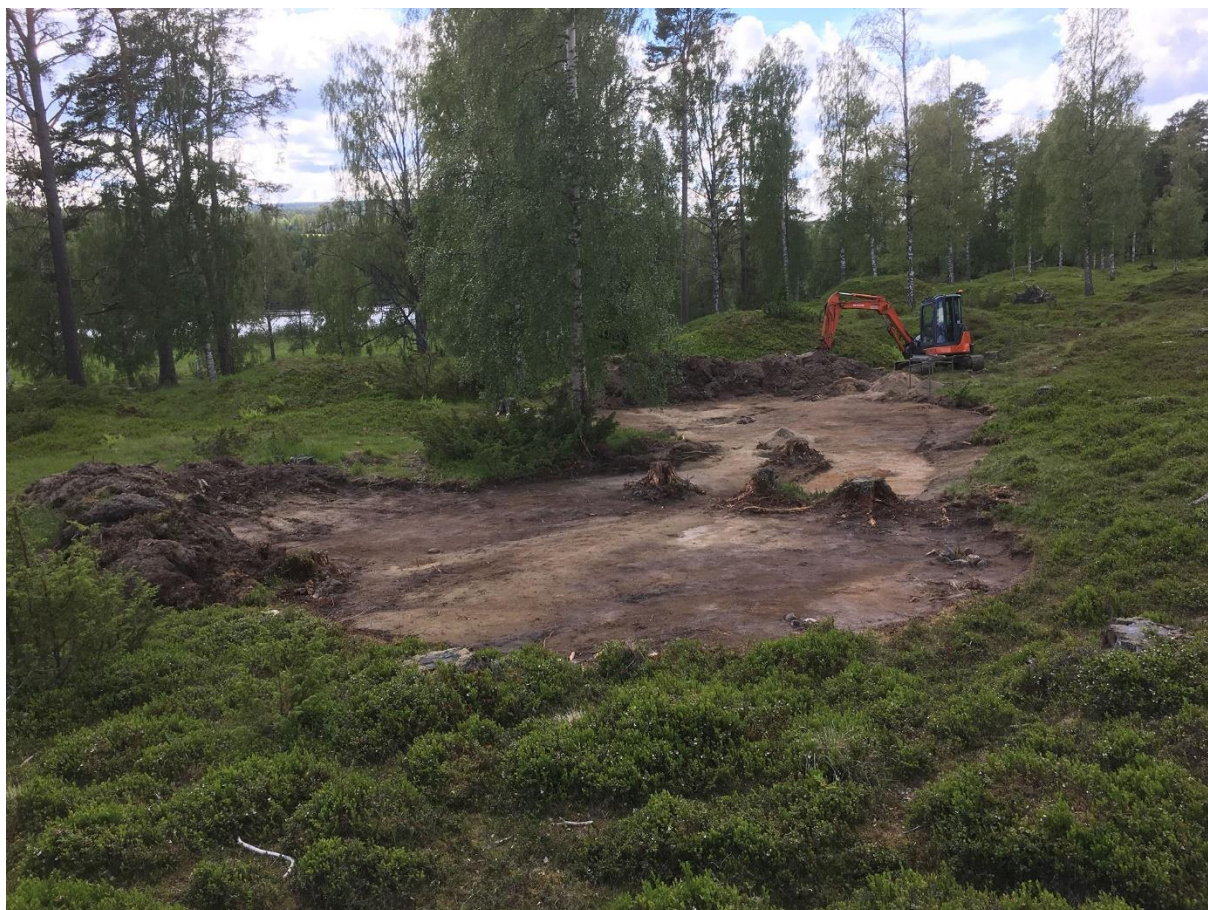
Figur 4. Översikt av schaktet. Foto från nordöst.
