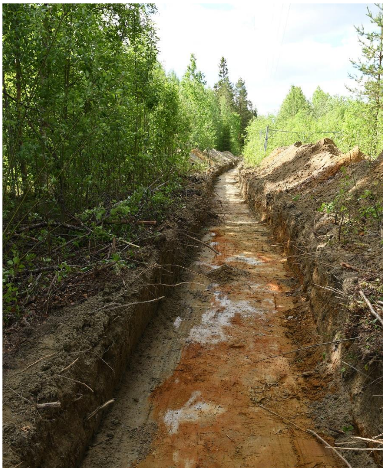
Mellersta och norra delen av schaktet.
