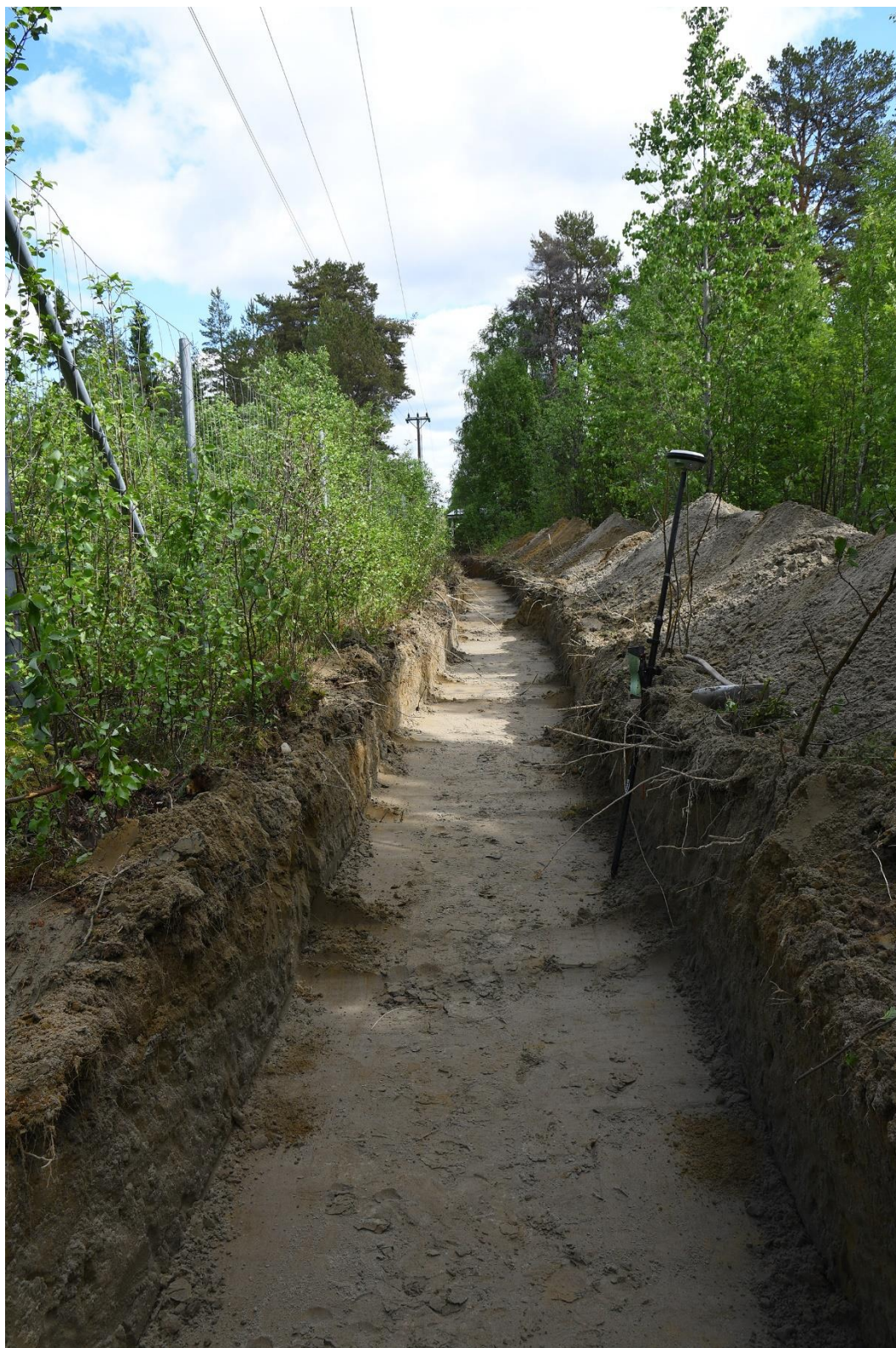
Figur 4. Mellersta delen av schaktet. Foto från sydväst.
