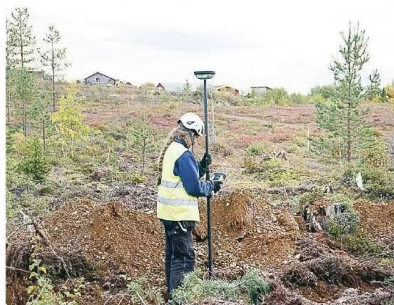
Positionerna bestäms av en satellitmottagare. I bakgrunden syns den gård som ska flyttas när den nya vägen är klar.
