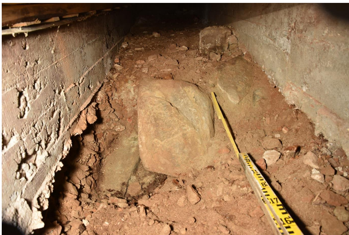
Figur 13. Fundament av stenblock i andra facket från korets östra grund. Foto från söder.
