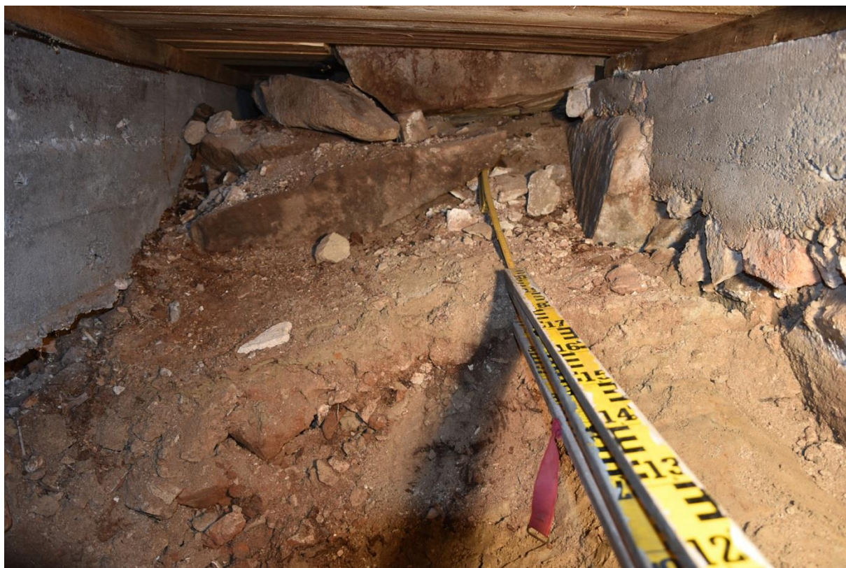
Figur 12. Fundament av stenblock vid korets östra grund. Foto från söder.
