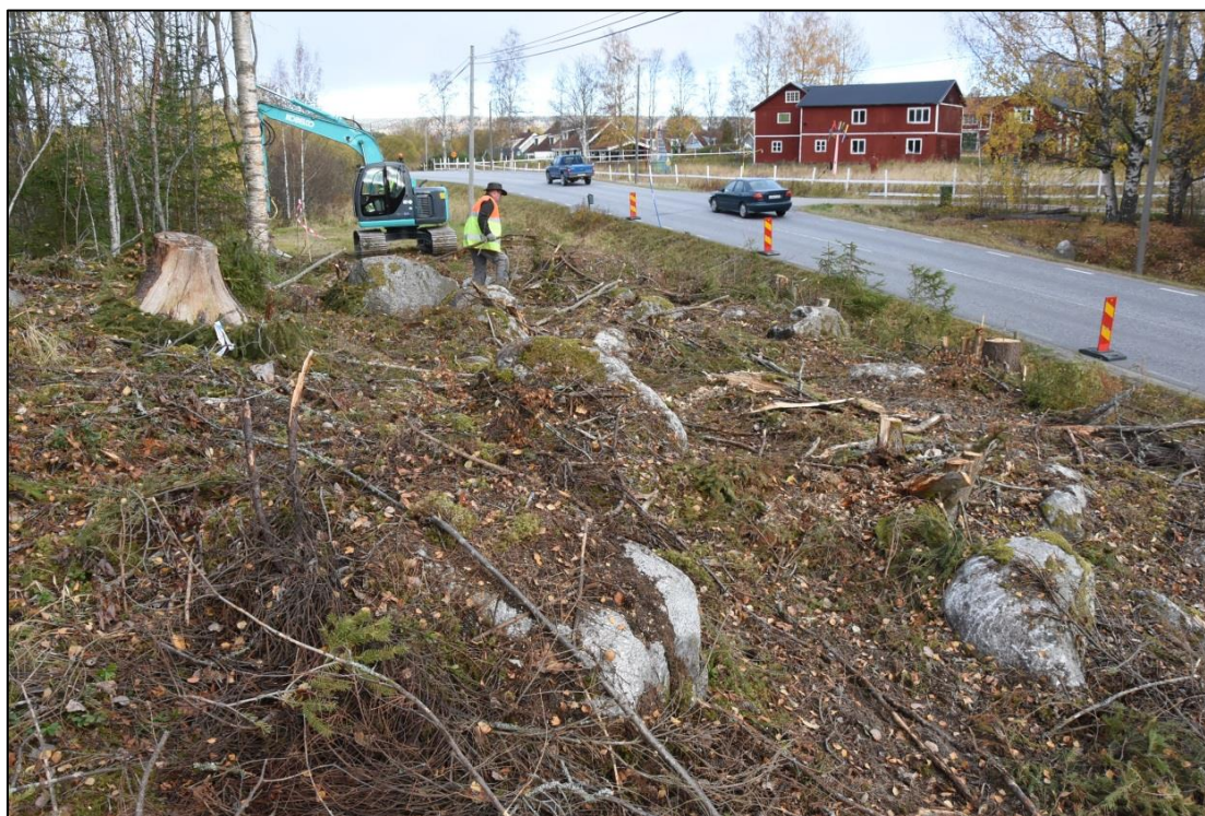
Fig. 7. Södra delen av UO2. Foto mot norr.
