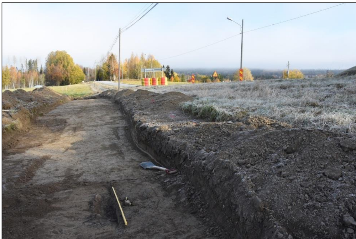
Fig. 14. Mittersta delen av schaktet, A3 vid tumstocken. Foto från söder.
