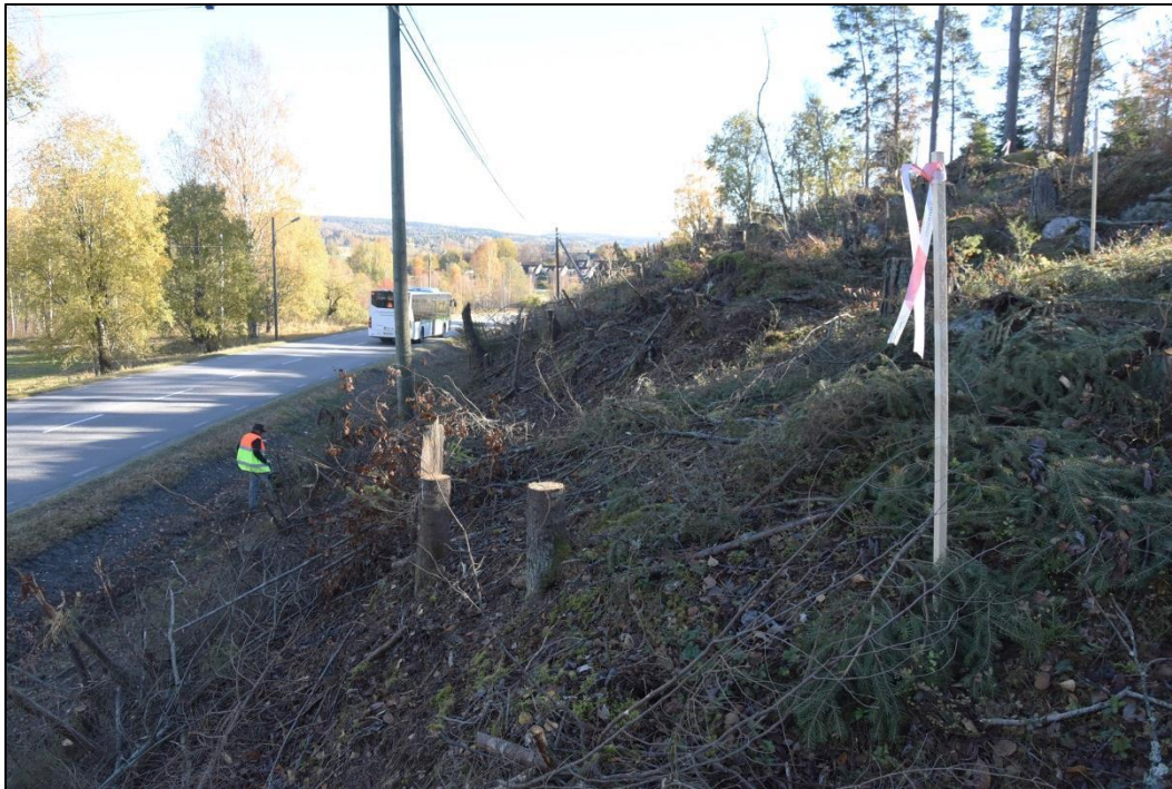
Fig. 4. Område 1, sett mot söder.
