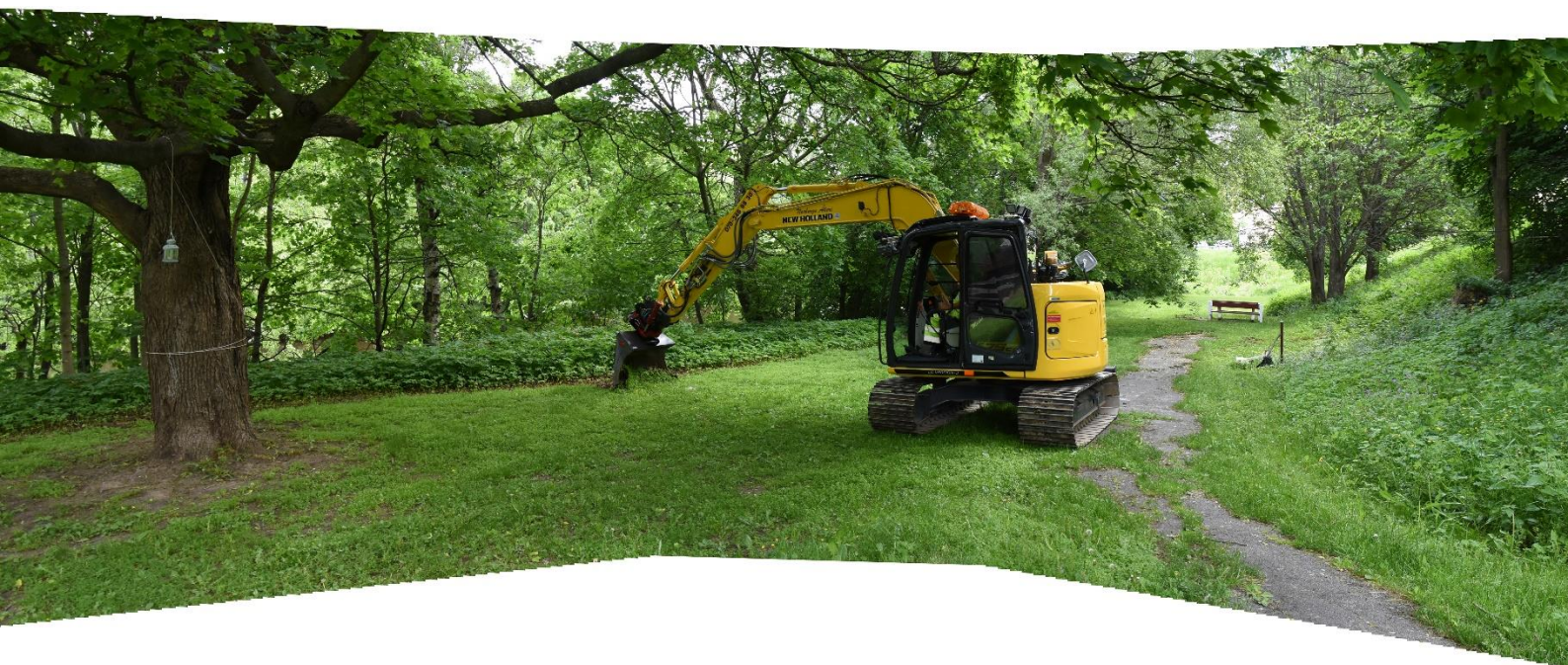
Figur 2. Utredningsområdets mellersta och östra delar. Sökschakt 1 ska strax öppnas.
