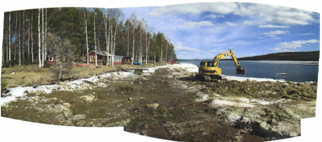
Figur 19 ovan. Undersökningsytans centrala och östra delar 2016-04-12.
