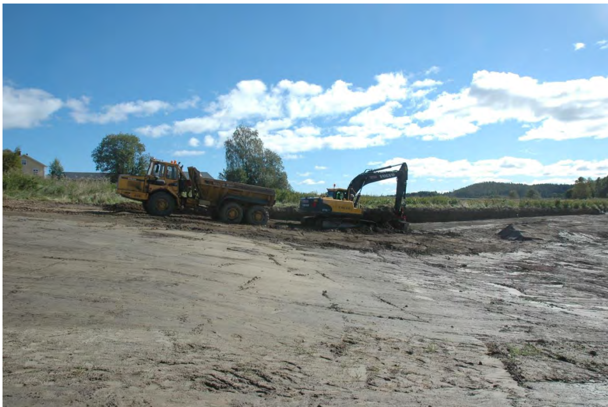
Figur 1. För att transportera bort de stora mängderna jord i samband med avbaningen av de tjocka jordlagren användes dumper och grävmaskin.
