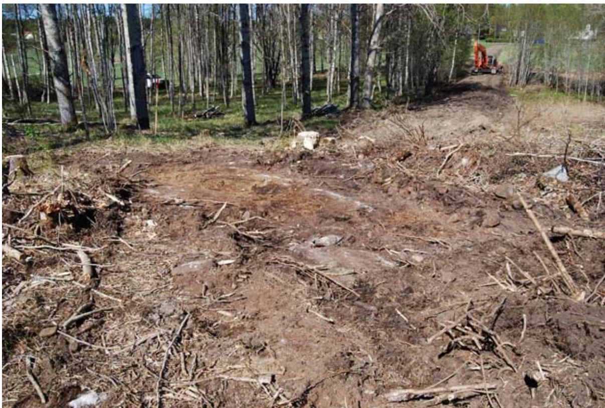
Fig. 6. Schakt vid röse nr 45. Fotat från S-SSÖ. Bygget av vägen har påbörjats från landsvägen (vid husen som skimtar bakom grävmaskinen). Gravfältet Raä 26 ligger in bland träden och till vänster, med en smal åkeryta mellan röseområdet och gravarna.
