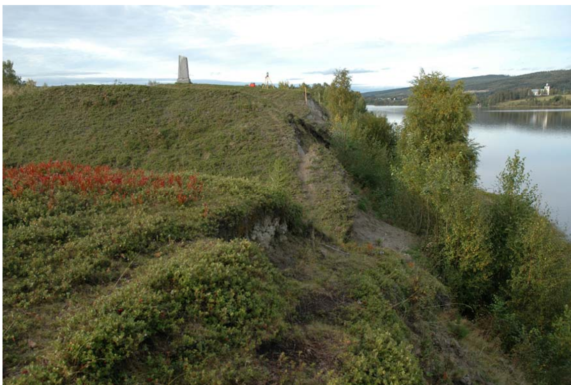
Erosionsskador på södra, mellersta och norra platåerna. Fotot taget från Syd.
