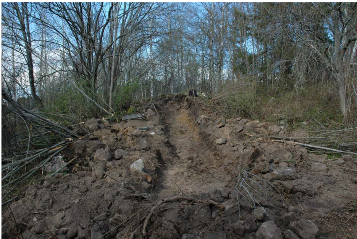
Schaktet i graven. Foto från söder.
