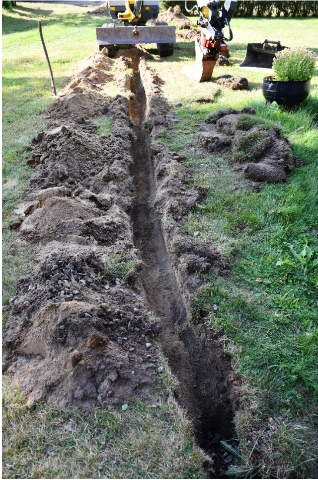
Figur 24. Schakt på tomt längst norrut. Foto från norr.
