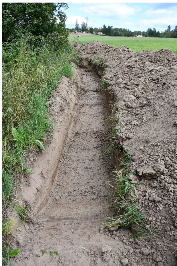
Figur 13. Schakt i mittendelen av undersökningsområdet på åkern. Lera fanns i botten. Foto från väster.
