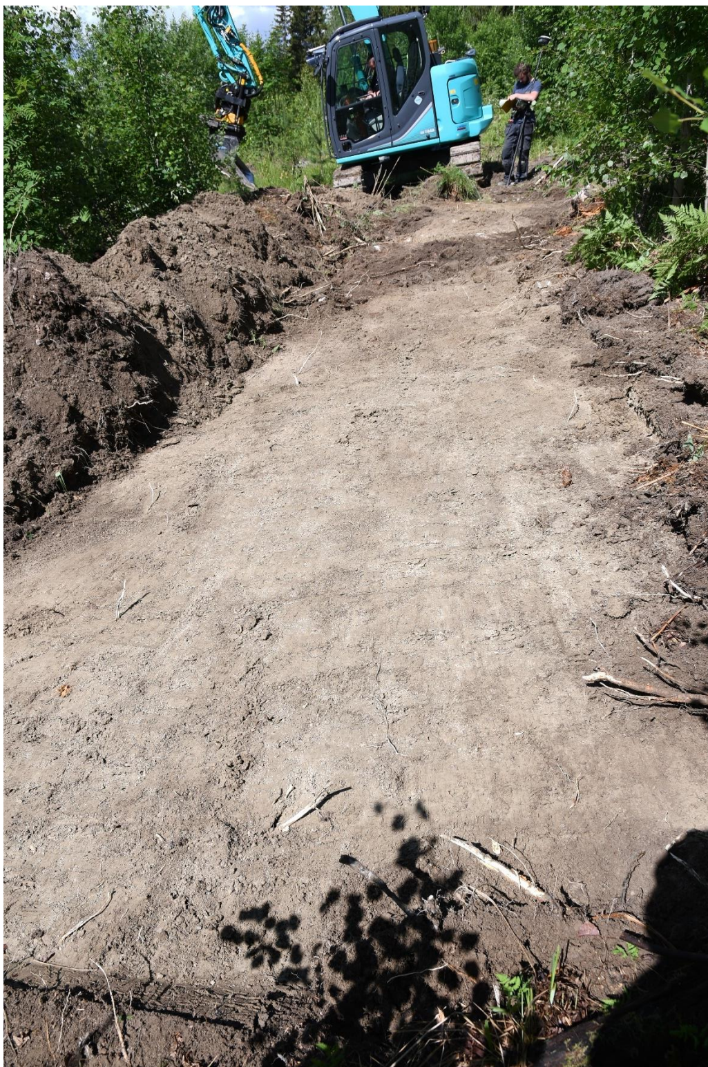
Figur 11. Schakt 19 från öst.
