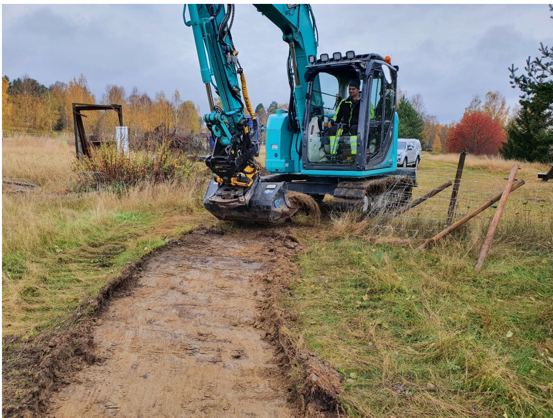
Figur 2. Grävmaskinist Erik Bergman torvar av vid ingången. Foto från söder.
