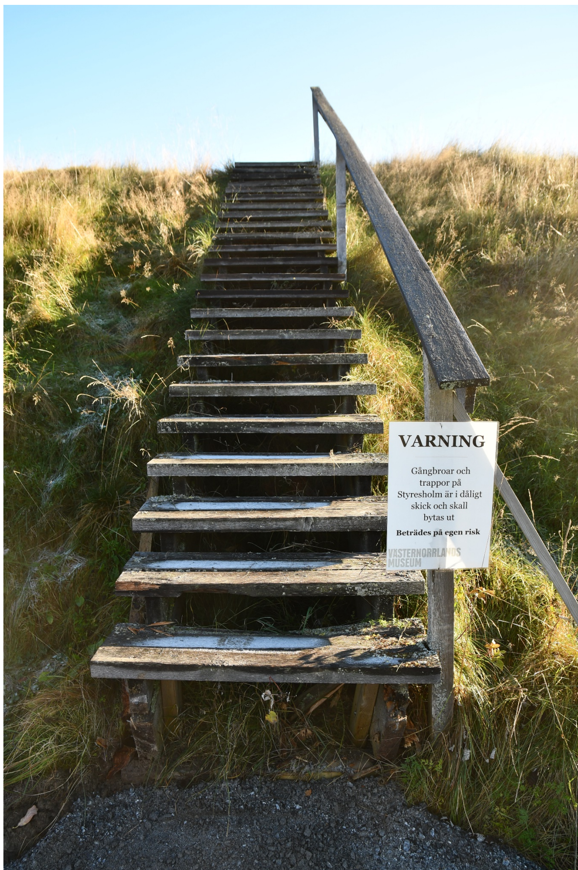
Figur 12. Trappor med varningsskylt. Foto från öster.
