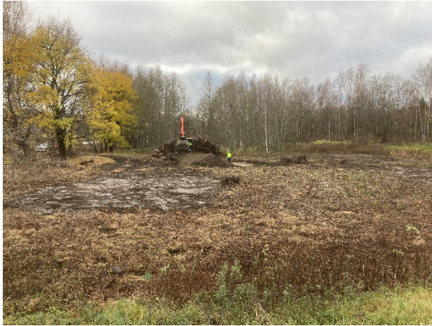
Fig. 12. Översikt norra delen av UO. Schakt 13 påbörjat. Foto från NÖ.
